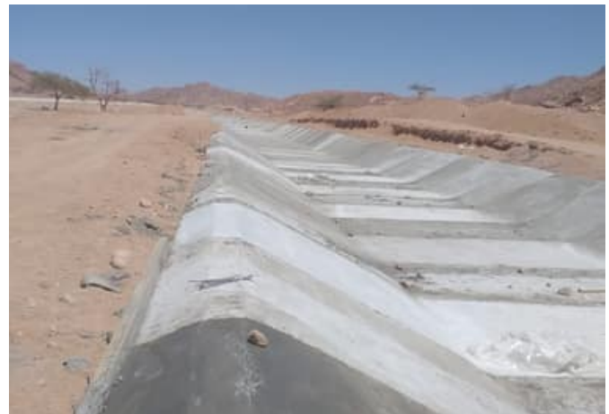
Channel concrete pour
